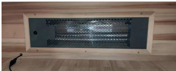
Prepojený kábel podlahového ohrievača
