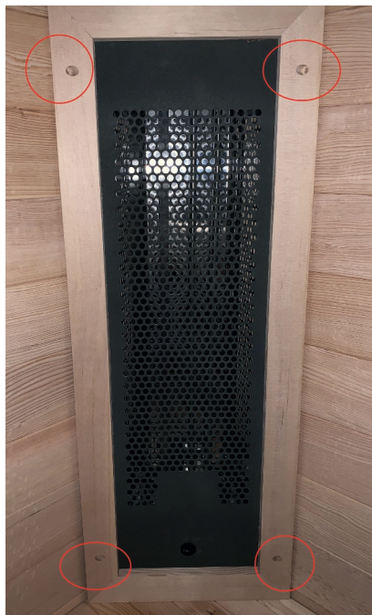
Umiestnený rohový ohrievač – vzdálenosť od podlahy 8cm
